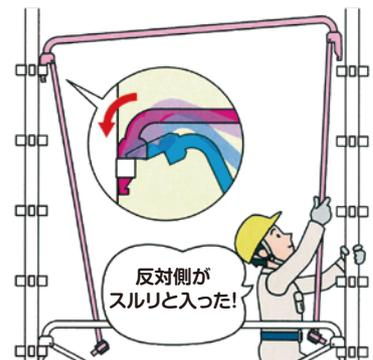
② もう一方の金具を支柱ポケットに取り付けます。
