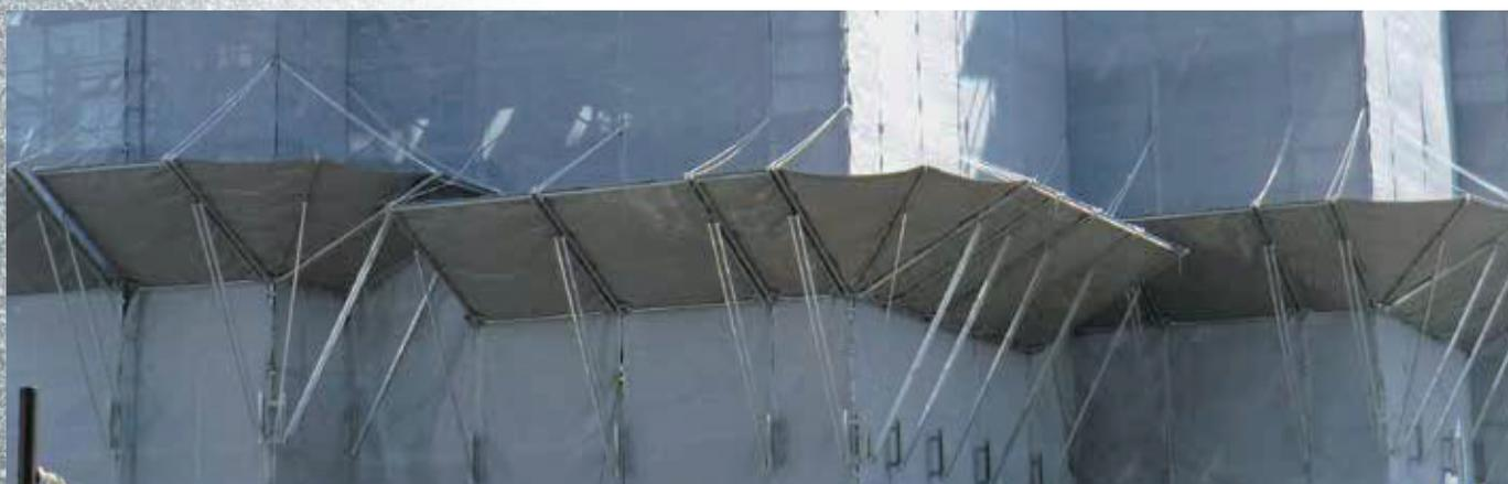
落下物の飛び出し防止のため、朝顔の水平角度は30°
