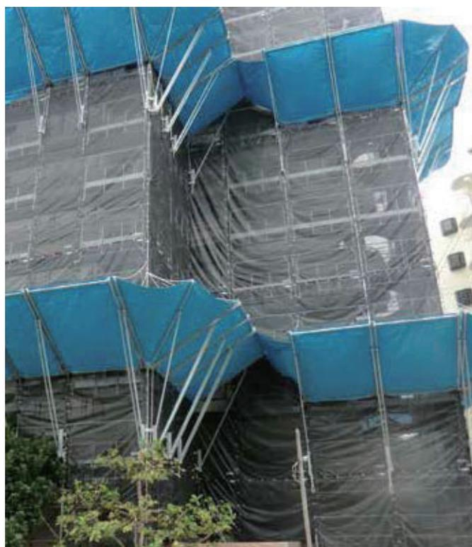
隙間用のシートで隙間養生可能
