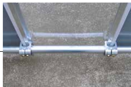
※固定部状況 (裏側から見る)
